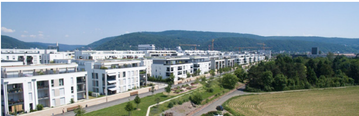
Figura 5 Bahnstadt District Heidelberg
